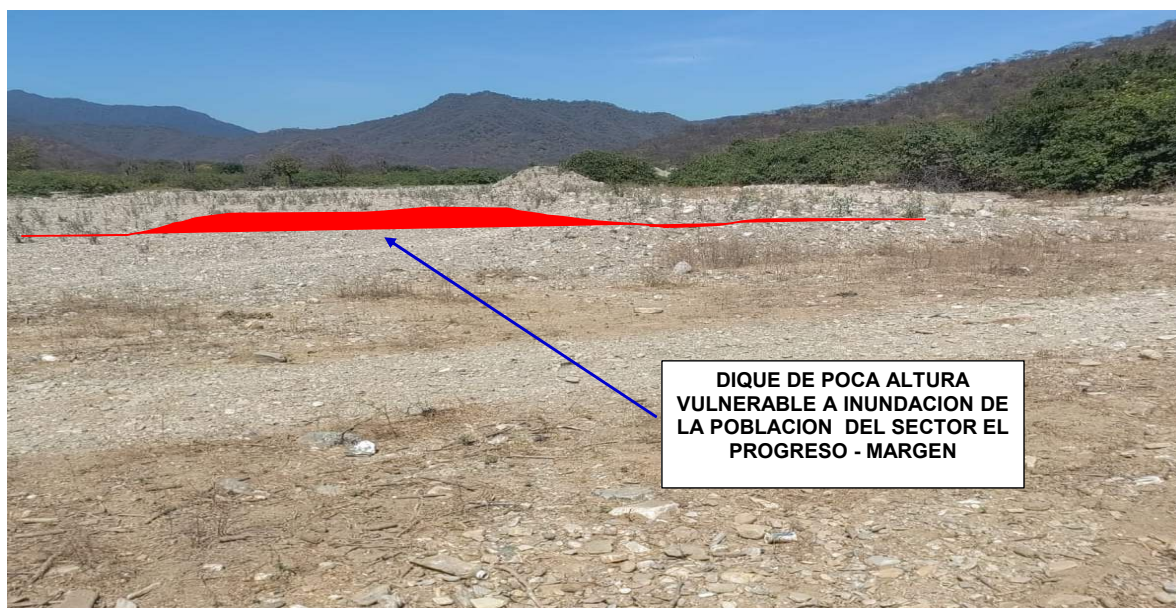
FIGURA N°02: TRAMO CRÍTICO EN EL RÍO PIURA MARGEN IZQUIERDA, EN EL SECTOR EL PROGRESO, DISTRITO DE HUARMACA, PROVINCIA DE HUANCABAMBA - PIURA.
